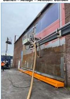
**Le robot permet de capter l'eau au niveau de la tête => aucune fuite n'est détectée**
