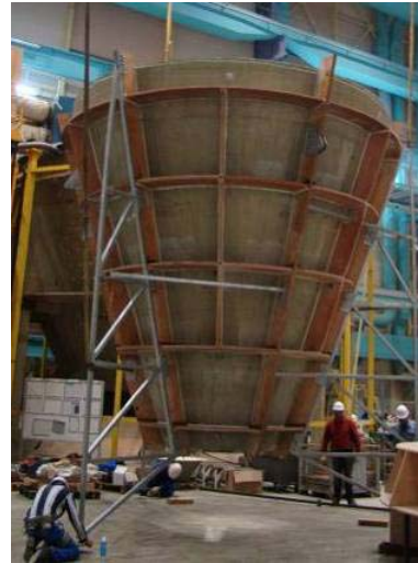
Figure 32 : Réglage du moule
