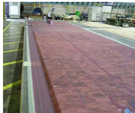
Figure 29 : Platelage après infusion
