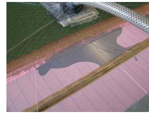
Figure 8 : Canalisation de la résine par joints d'étanchéité
