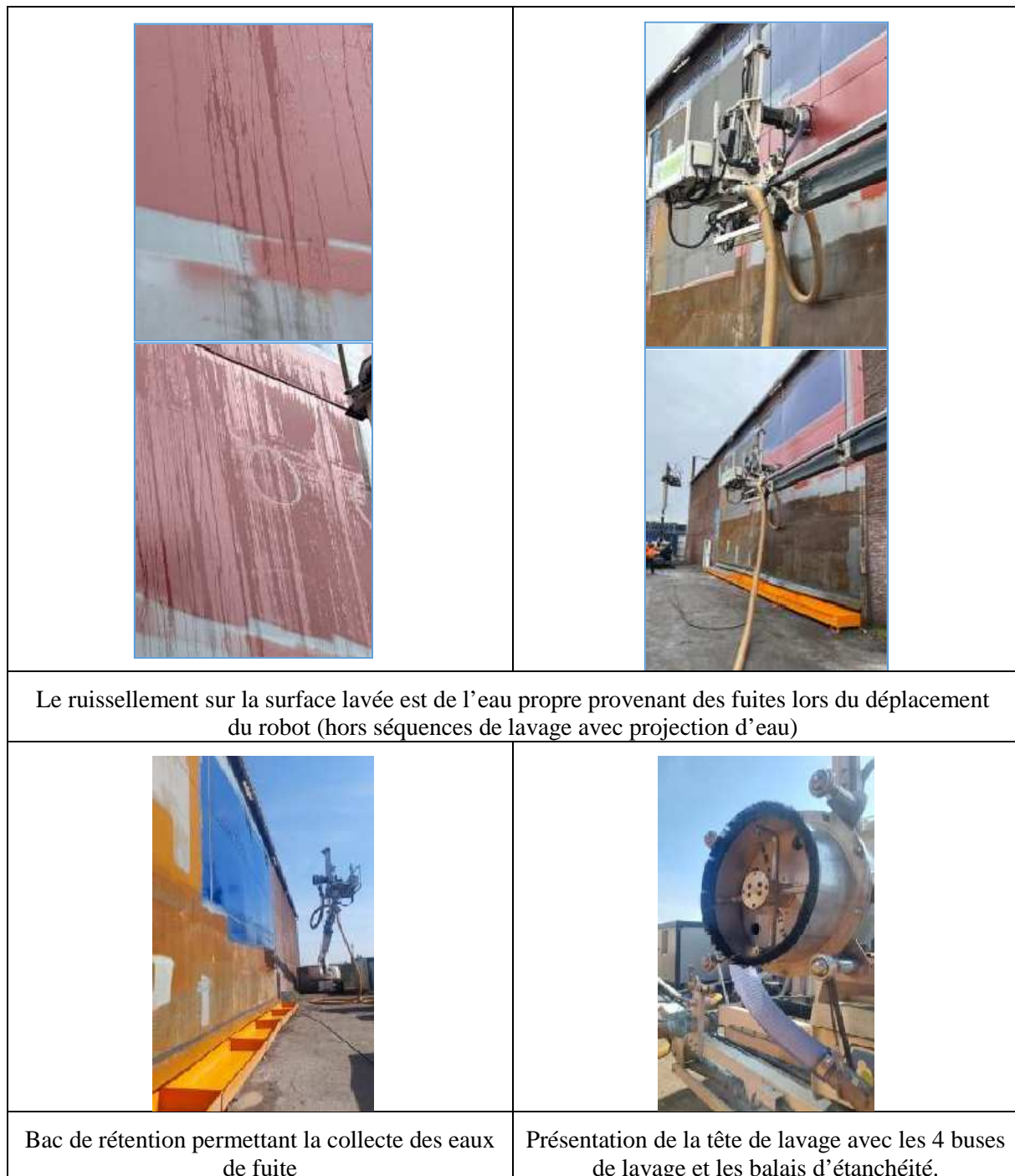
Figure 4: Photo de présentation du lavage
